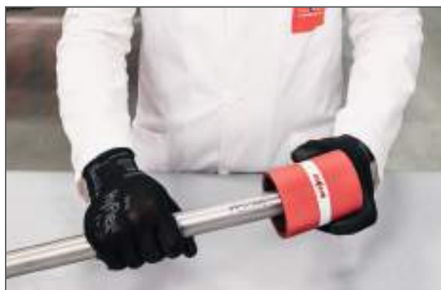
Sbavatura del tubo / Deburring the pipe
